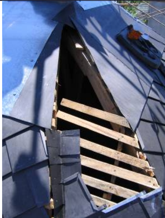
Fotografía 14 - Colocación de las tejas Metálicas
