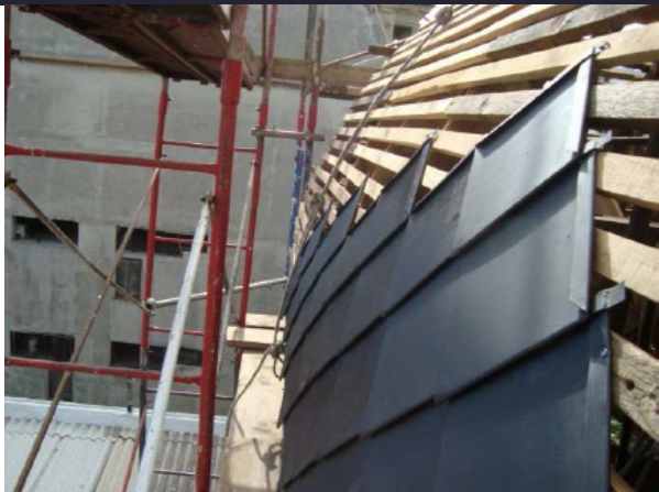
Fotografía 5 - Listones de apoyo de las tejas
