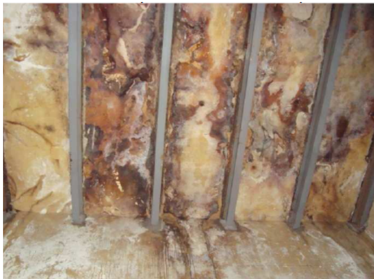
Fotografía 13 - Reconsolidación estructural, colocación de perfiles de sustentación
