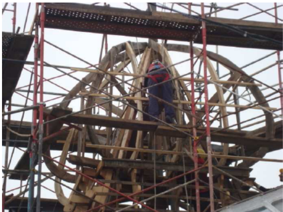
Fotografía 7- Estructura de madera
