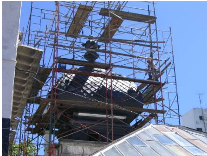
Fotografía 12 – Andamios y apuntalamientos
