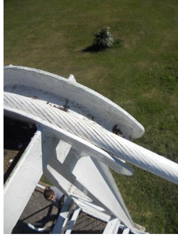
Figura 16: Apoyo del cable sobre la torre
