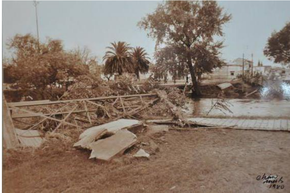
Figura 2: Estado del puente de calle San Martín. Inundación año 1980
