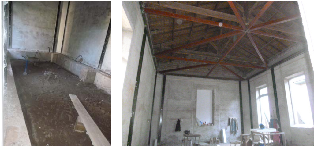
Figura 9 – Recuperación de cámara de ventilación y estructura metálica de conexión
