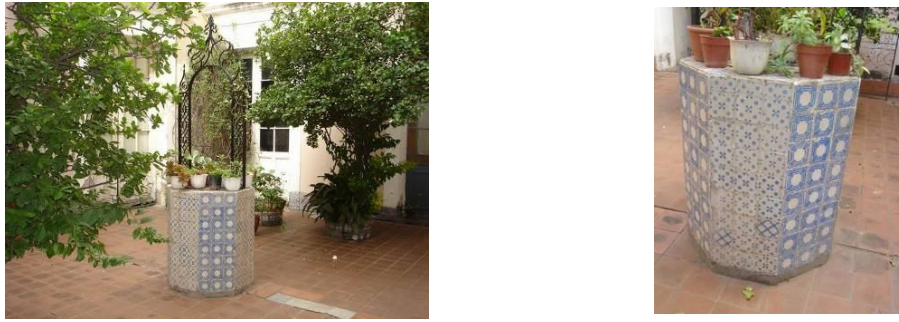
Figura 3. El aljibe elemento necesario de estas casas para la provisión de agua
