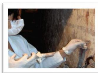
**Figura 7 - Aplicación del mortero de inyección.**
