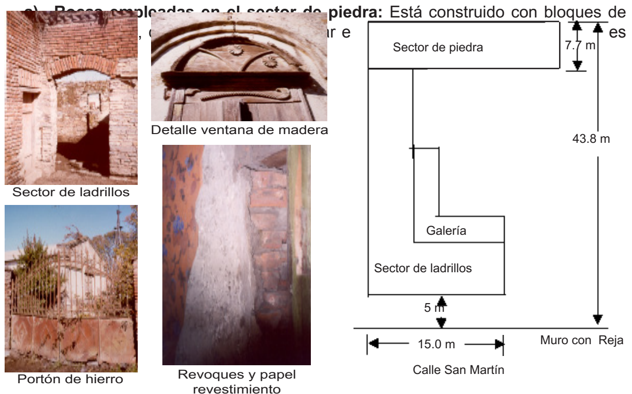
Figura 4: Vivienda desocupada. Esquema de planta y detalles.
