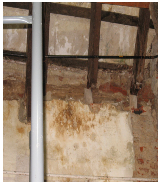
Fotografía 12. Soleras embutidas en la mampostería.
