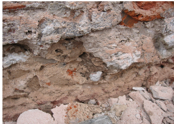
Fotografía 7. Muros: ladrillos y piedras del Río Paraná.
