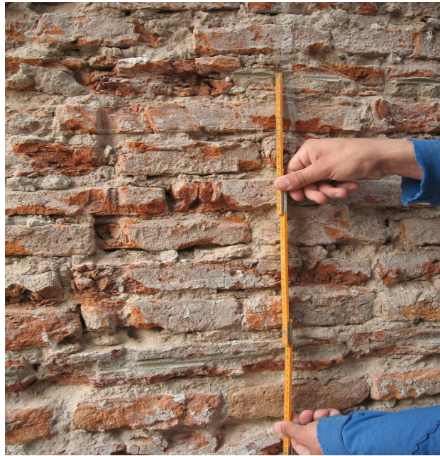
Fotografía 30. Registro de la geometría de los bloques.
