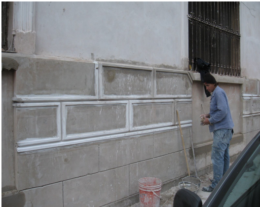
Fotografía 31. Reconstrucción de los sillares.
