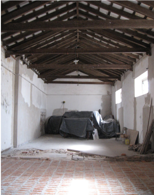
Fotografía 8. Entrepiso entre Sala I y Sala II.
