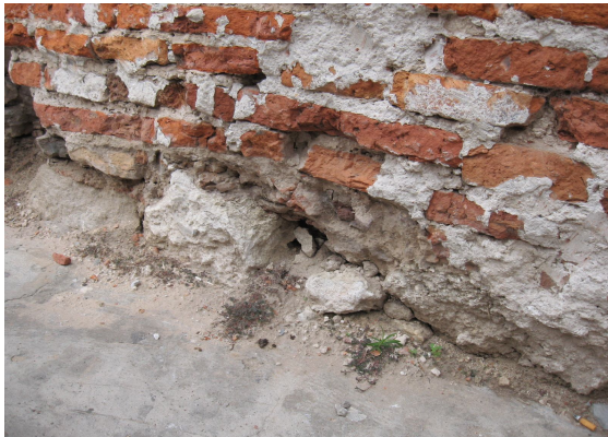
Fotografía 6 . Cimientos de piedras, ladrillos y cal.
