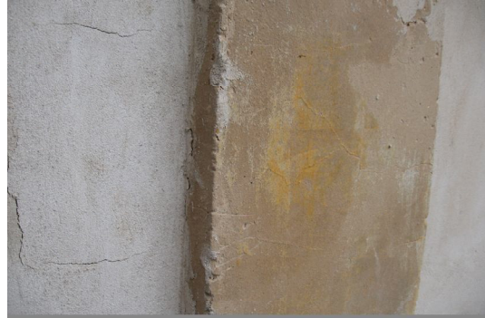
Fotografía 34. En los intradós de los vanos.
