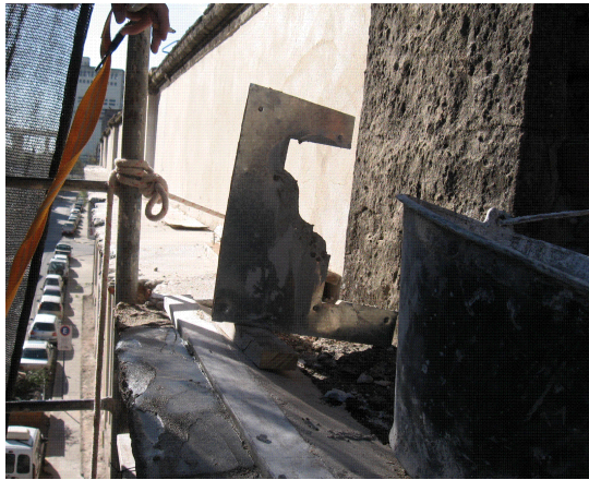
Fotografía 23. Moldes de chapa.
