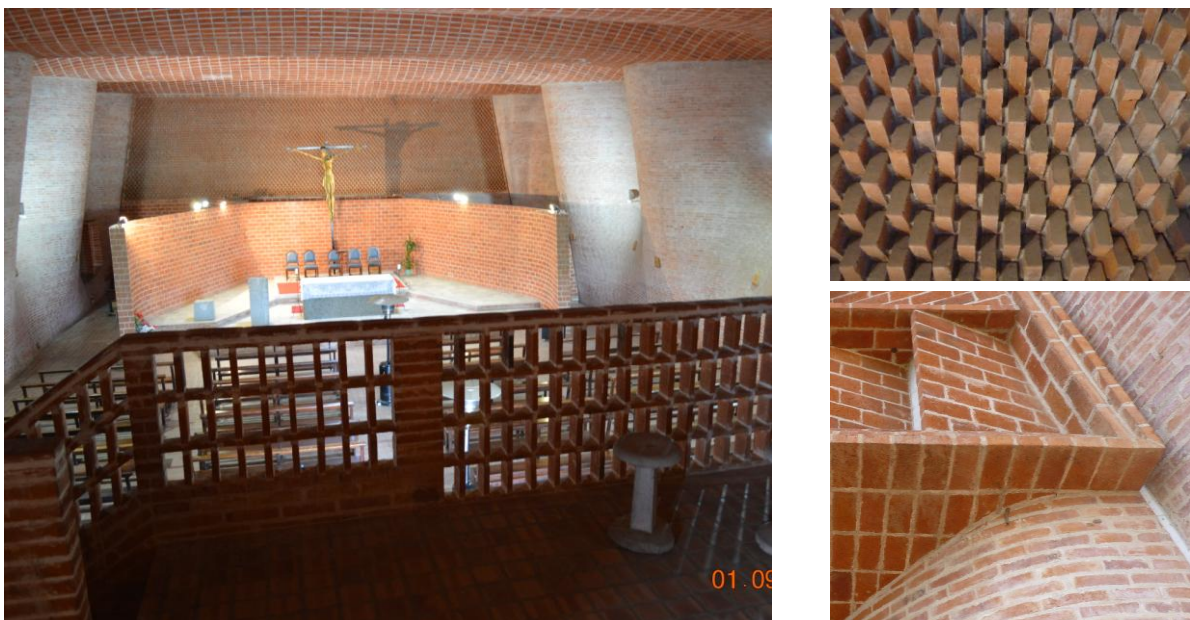
Figura 2: Espacio interior de la nave principal, detalles de la disposición variada de los ladrillos
