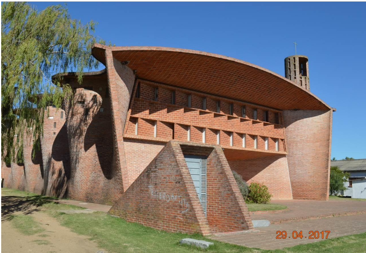
Figura 1: Vista de la iglesia desde el acceso principal
