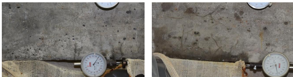
Figura 8. Aspecto de la superficie de las vigas R y FR a la edad de 5 meses.
