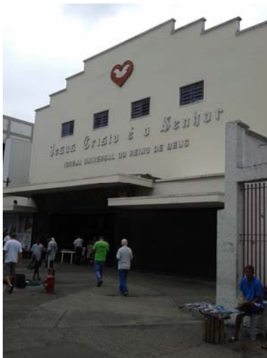
Figura 4 – Fachada da Igreja instalada em antiga sala de cinema tombada pela Prefeitura em Campo Grande. Fonte: foto do autor.
