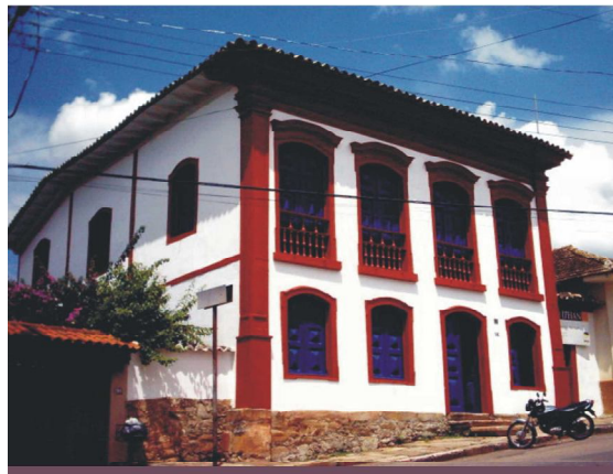
FIGURA 2 – Edificação que abriga o Museu Regional de Caeté Fonte: Kleumanery de Melo Barboza
